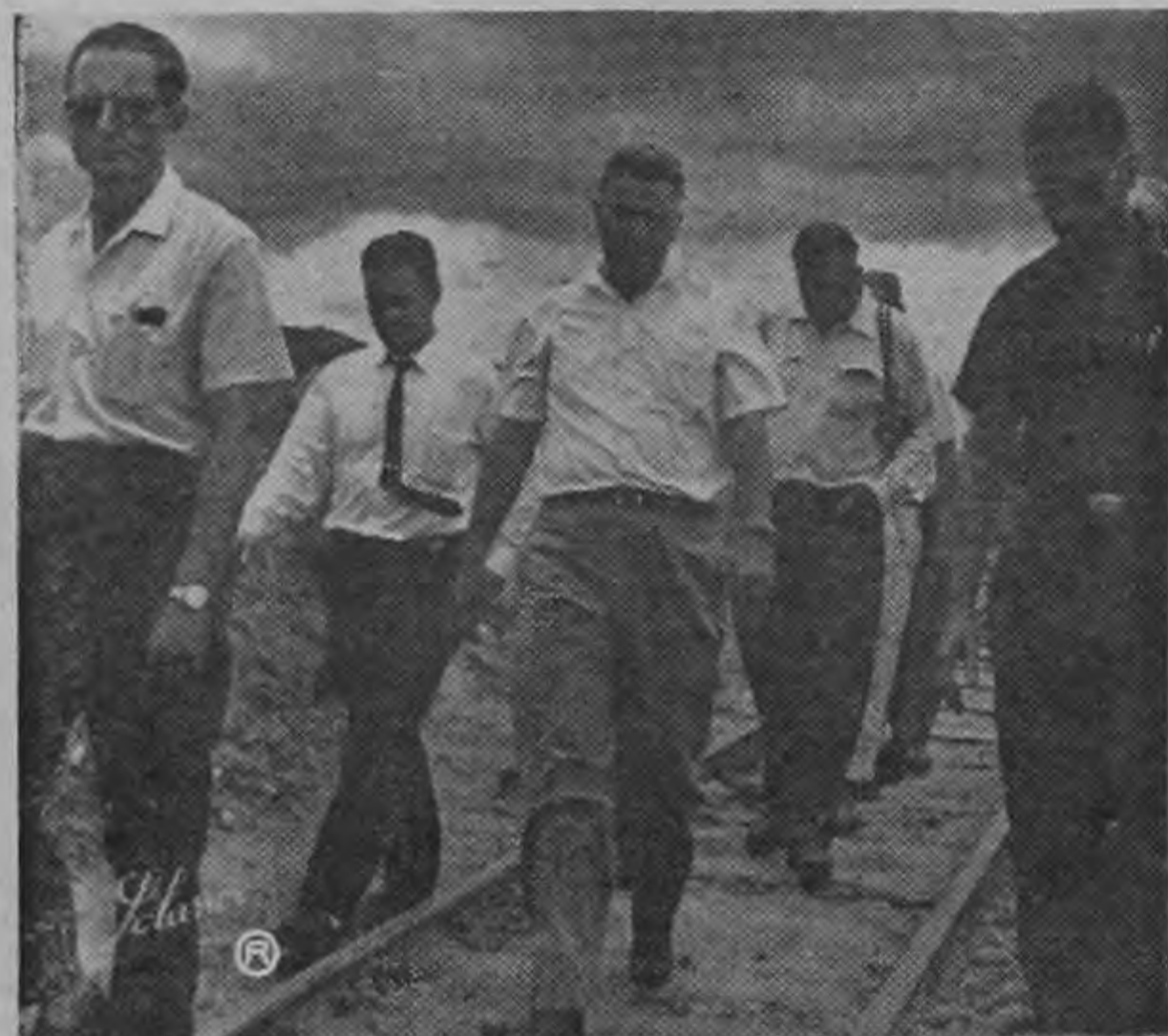
INSPECCION SOBRE LA VIA FERREA DE LA NORTHERN al Norte de Taras, donde puede observarse que el puente que allí tenía el Ferrocarril para atravesar el Río Reventado está completamente obstruido y el cauce del río pasa por sobre los rieles. Al centro, el Sr. Ministro de Transportes, al cual acompañan el Ing. León Venegas; miembros de la Asociación de Carreteras y Caminos; nuestro Redactor Manuel Rojo del Río y otros colegas de la prensa.
